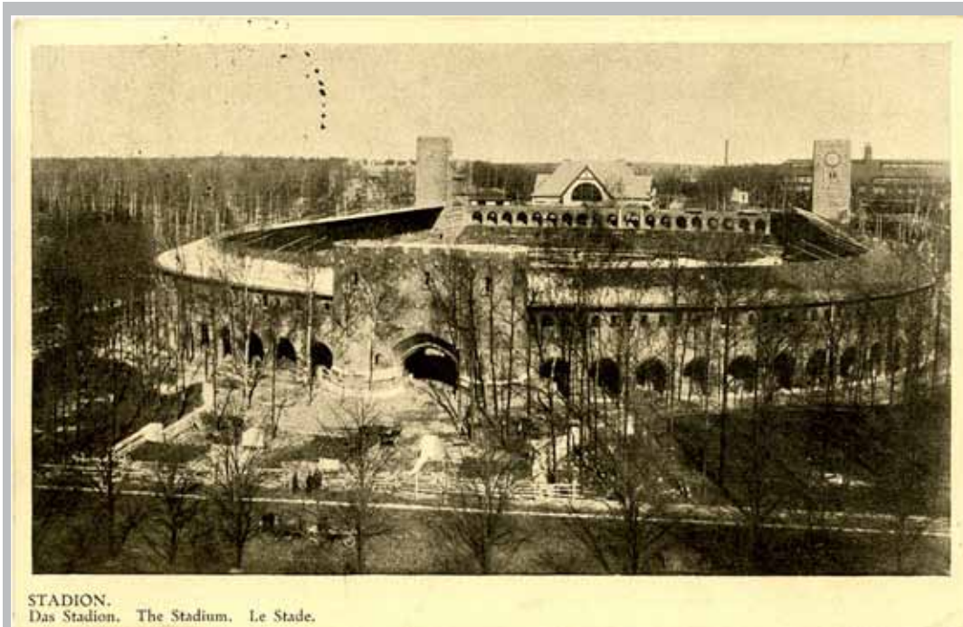
STADION (80) Torben Grut ville i Stockholm bygga en idrottsanläggning som var funktionell, både för åskådare och tävlande. Dessutom ville han skapa en vacker byggnad i en nationell svensk stil.
